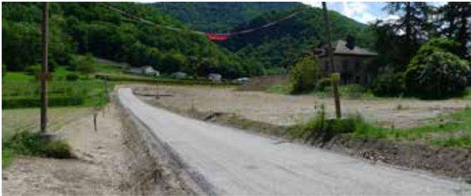
Les travaux de viabilisation du projet immobilier Grandes vignes sont en cours de réalisation. Ils comprennent pour cette première phase la création des réseaux d'eaux usées, pluviales et potable (avec réservation d'emplacement pour la canalisation gaz) et la réalisation d'une voirie provisoire.
