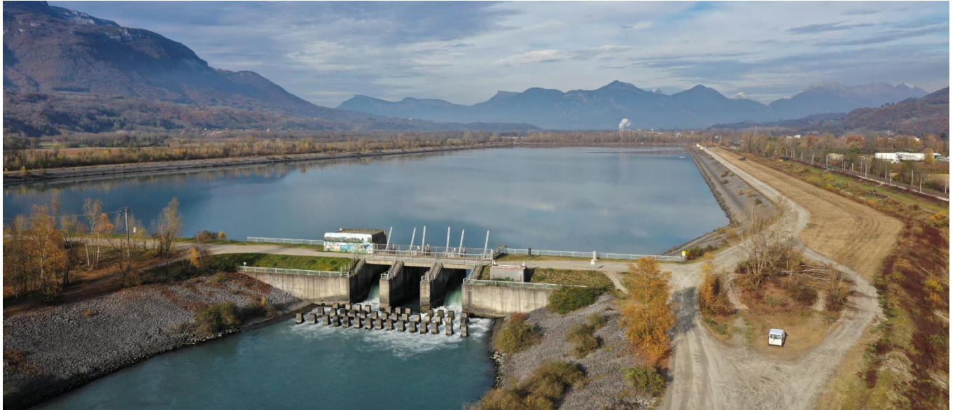
Figure 10 : Ouvrage de restitution des eaux du bassin Cheylas, au sud
