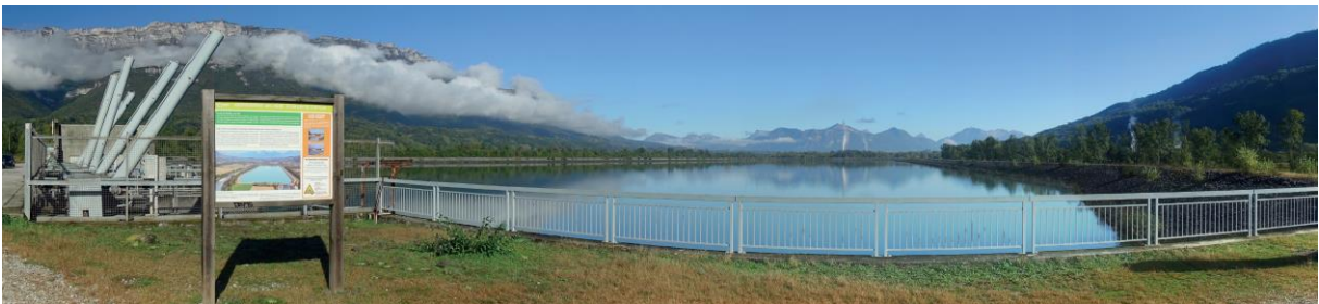
Vue depuis les abords au sud du bassin industriel du Cheylas (Source : étude d'impact, juillet 2020)
